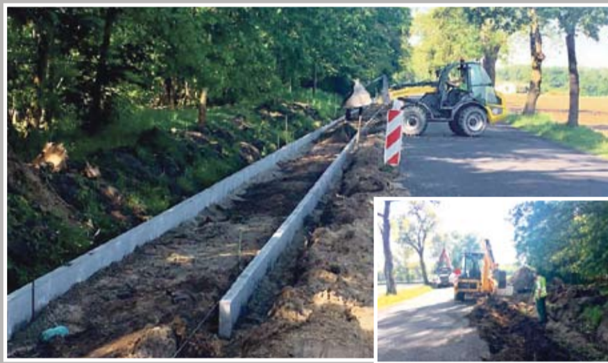
Ścieżka rowerowa Bełęcina - Zakrzewo
